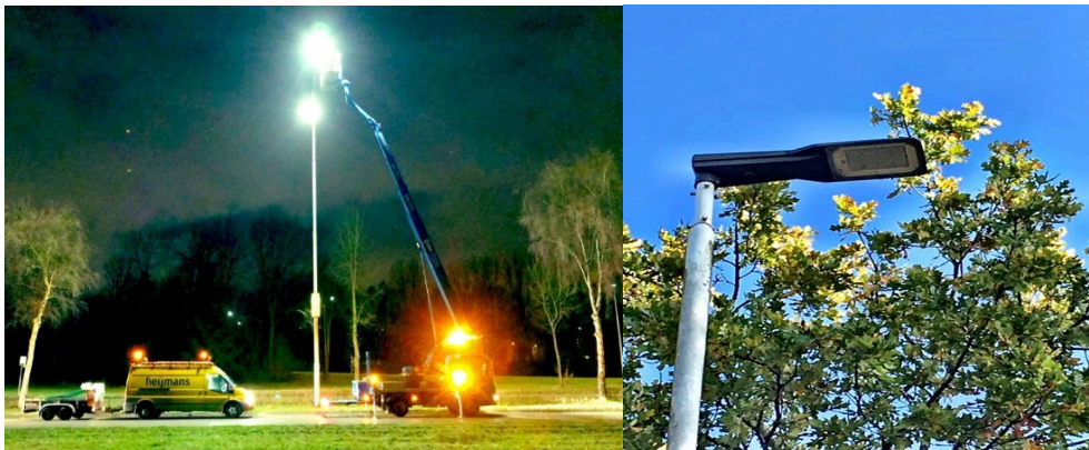
Figuur 4 Heijmans plaatst de slimme armaturen. Foto's: website jouwlichttop040.nl
